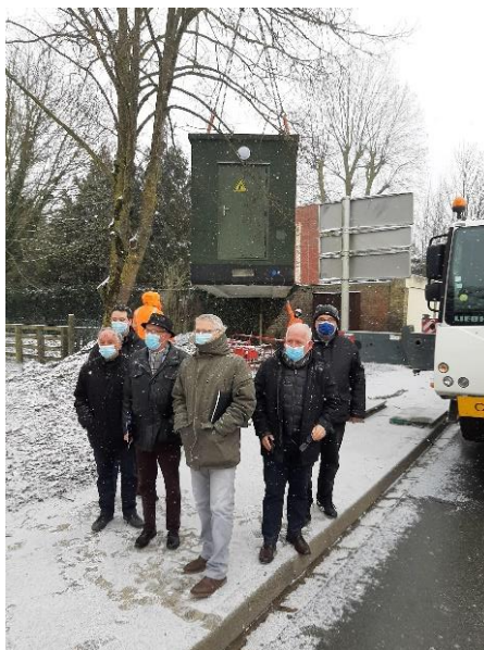
Pose du NRO Ham sous les flocons
